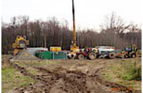
Szczecin - Gdansk w budowie
