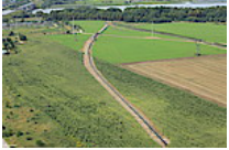
Swinoujscie - Szczecin w budowie
