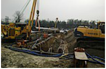
Gustorzyn-Odolanow w budowie
