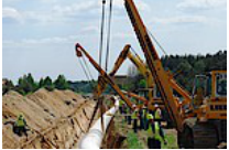
Rembelszczyzna - Gustorzyn w budowie
