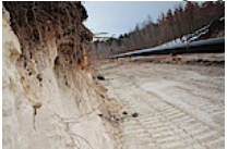
Szczecin - Lwowek w budowie
