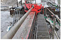
Przebiert HDD pod rzeka Wisla
