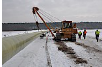
Przewiert HDD pod rzeką Wisłą
