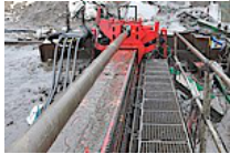
Przełaz HDD pod rzeka Wisła
