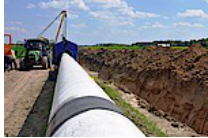
Rembelszczyzna - Gustorzyn w budowie
