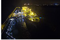
Dostawy LNG do Terminalu
