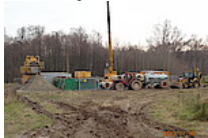
Szczecin - Gdansk w budowie
