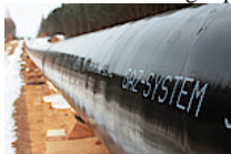
Szczecin - Lwówek w budowie
