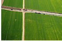
Rembelszczyzna - Gustorzyn w budowie
