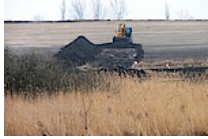
Gustorzyn-Odolanów w budowie
