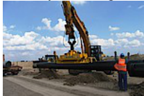
Gustorzyn-Odolanow w budowie
