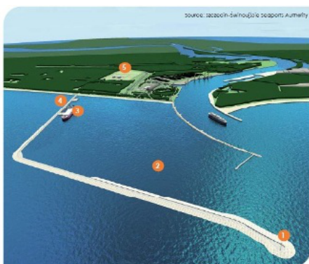
Model of LNG Regasification Terminal in Świnoujście
